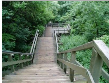
Figure 48 – Escalier de 400 marches (Cap blanc, ville de Québec)
