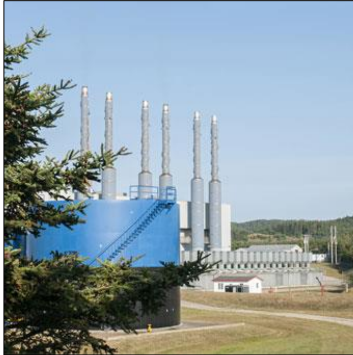
Figure 107 – Centrale thermique des Îles-de-la-Madeleine
