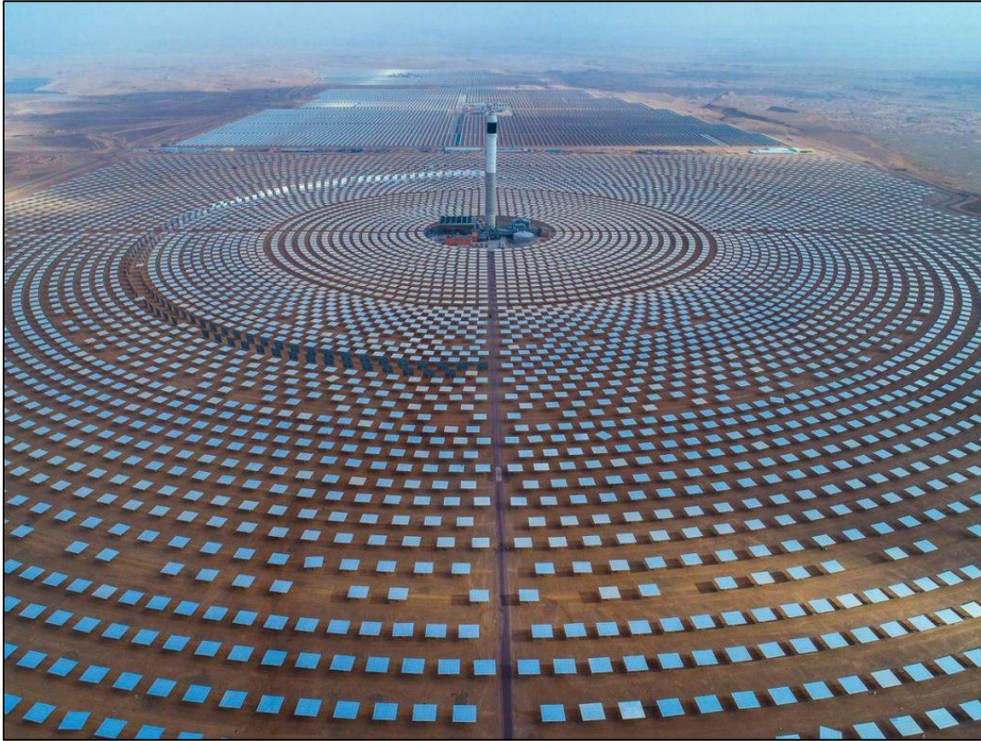
Figure 111 – Ferme solaire Noor (Maroc)
