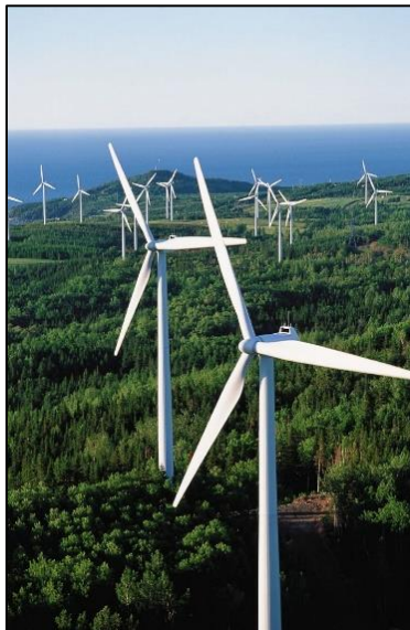
Figure 118 – Parc éolien Le Nordais (Gaspésie)
